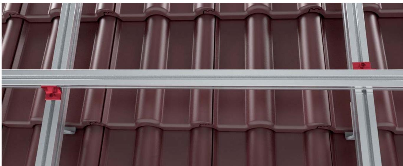
Profil 40 × 40: Bei Verwendung eines Kreuzverbinders je Verbund ist der Kreuzverbinder wechselseitig anzuordnen.
